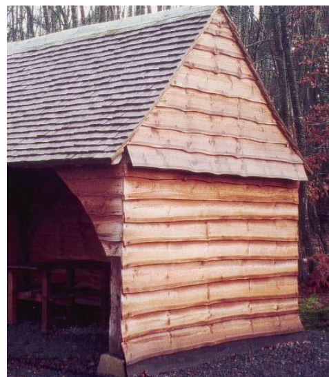
Photo-fig.8 : Toit de bardeaux fendus, faîtage de terre cuite et embarrures de chaux, voligeage de pin non déligné.
