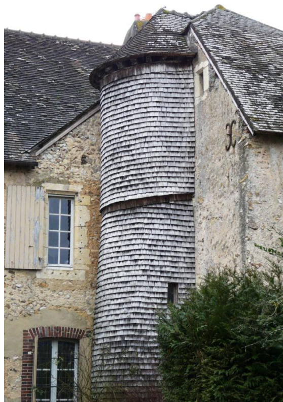
Photo 10 : un bel exemple de bardeaux en essentes dans le Perche.
