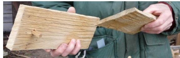
Photo 9 : autrefois, on fixait les bardeaux à l'aide de chevilles de bois.
